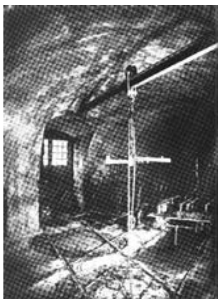
Ilustración 5. Lámparas de arco voltaico con reflectores utilizados por Félix Nadar para iluminar los túneles del sistema de alcantarillado de París, ca. 1861. Original negativo sobre vidrio (colodión húmedo). La Médiathèque del'Architecture et du Patrimoine. Wikimedia commons.
