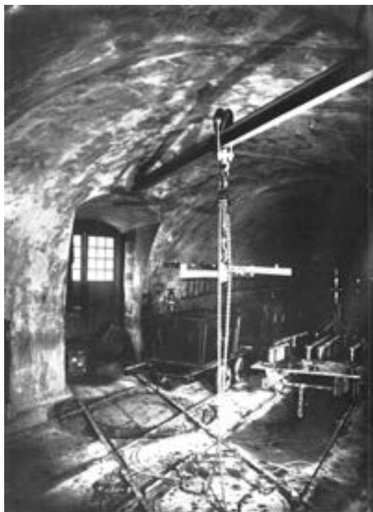
Ilustración 6. Interior de un túnel y pilas de Bunsen utilizadas para la iluminación artificial. Félix Nadar, ca. 1861. Original negativo sobre vidrio (colodión húmedo). La Médiathèque de l'Architecture et du Patrimoine. Wikimedia commons
